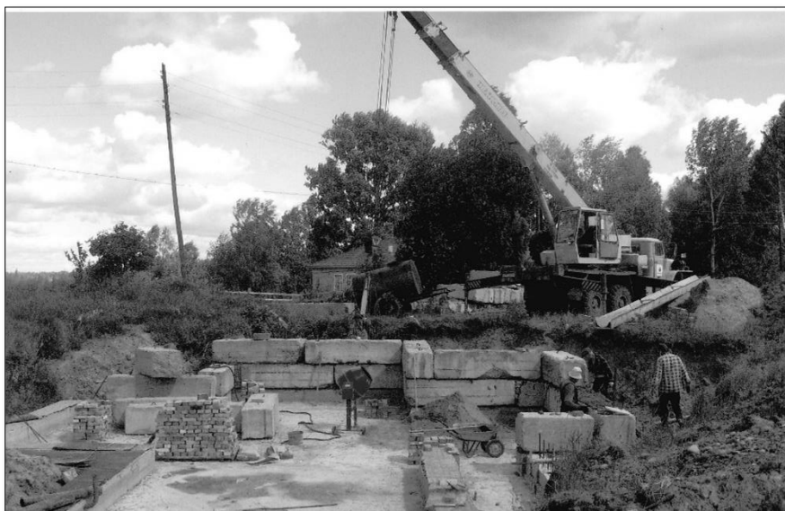
Лето 2011 года. Строительство фундамента и цокольного этажа
