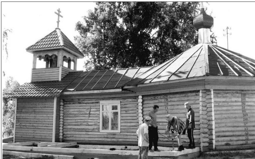
Лето 2008 года. Строительство воскресной школы наконец-то стало тепло.
